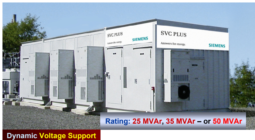
Bild 10: SVC PLUS zur dynamischen Spannungsstützung – Synergien HGÜ und FACTS
