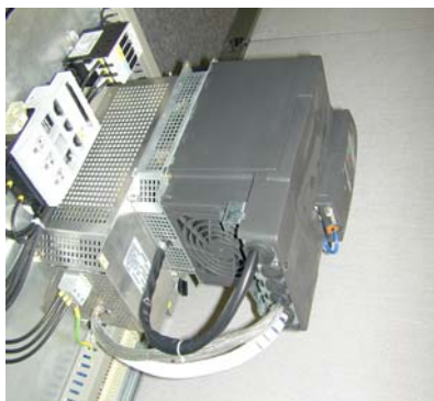
Bild 1 Umrichter mit standardmäßigem Sinusfilter, 5,5 kW
